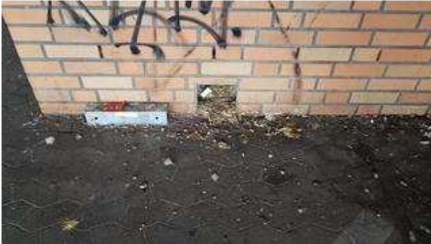
Rückfront: Bereich „b“ Parkplatz
