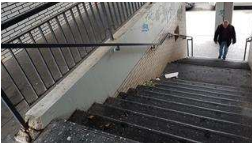
Treppenaufgang vom Parkplatz Bereich „d“ (LEG)
